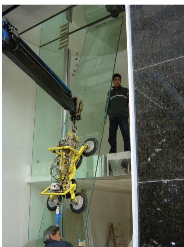
  El transporte de paneles se realiza mediante una gr a dotada de un sistema de ventosas.
