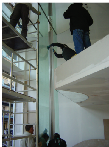
  Momento del montaje y fijaci n del vidrio a las carpinter as.
